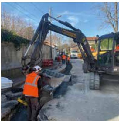
Les travaux ont débuté par des opérations de terrassement, puis se prolongent avec le raccordement progressif des foyers aux nouveaux câbles. Ils s'achèveront fin mars par des opérations de réfection de la chaussée effectuées par la Métropole de Lyon.
