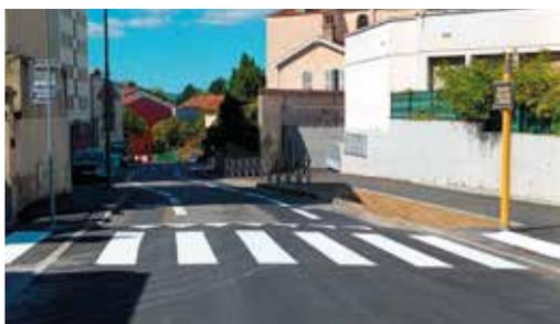
L'aménagement d'une Chaussée à voie centrale banalisée (CVCB) permet de "prendre en compte les cyclistes dans les cas rares où les contraintes géométriques et circulatoires rendent impossible le recours aux aménagements cyclables traditionnels"<sup>\*\*</sup>, pour garantir une
